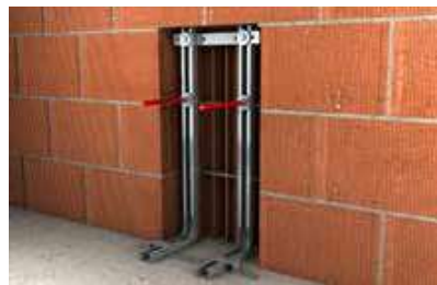
Dettaglio: installazione sistema L Plus
